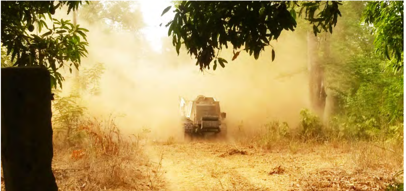
La machine DIGGER D-3 au travail après sa remise en état.
