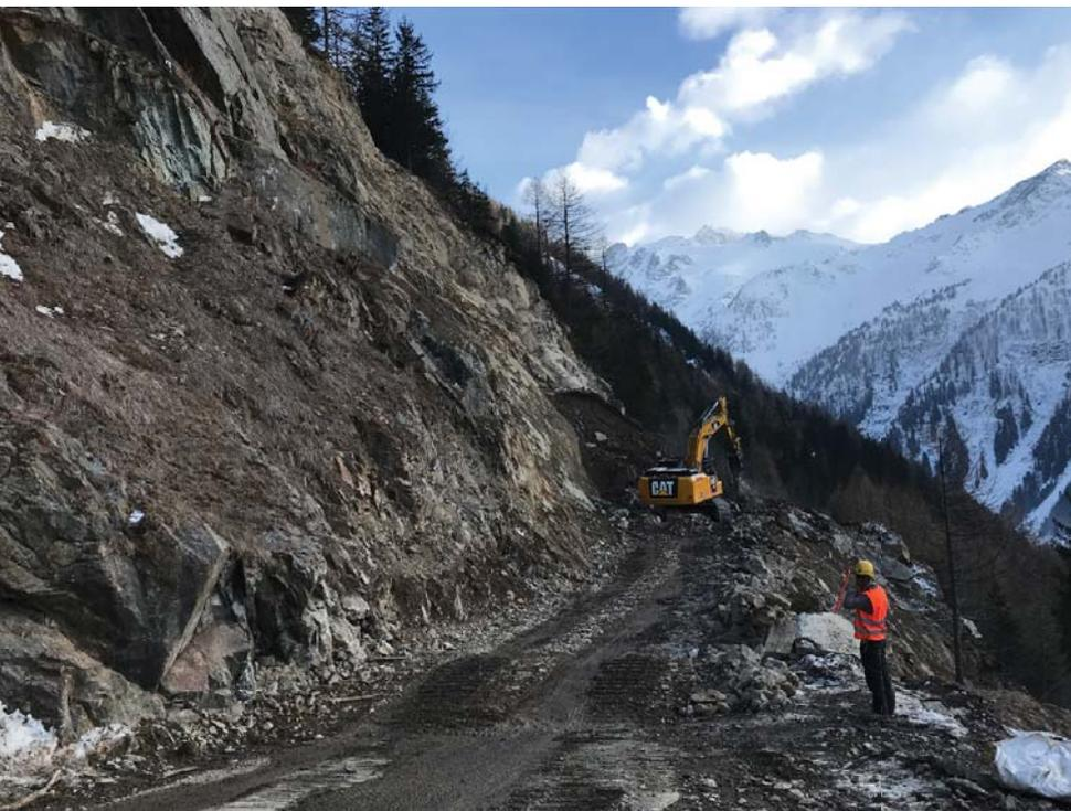
Lors du déblaiement de la route du col de la Forclaz (photos), entre Martigny et Trient, suite à l'éboulement du 13 janvier dernier, les excavatrices employées étaient équipées d'un système de télécommande classique, qui suppose que l'opérateur reste à proximité immédiate. Sa sécurité demeure relative, son point de vue limité et son confort précaire.
