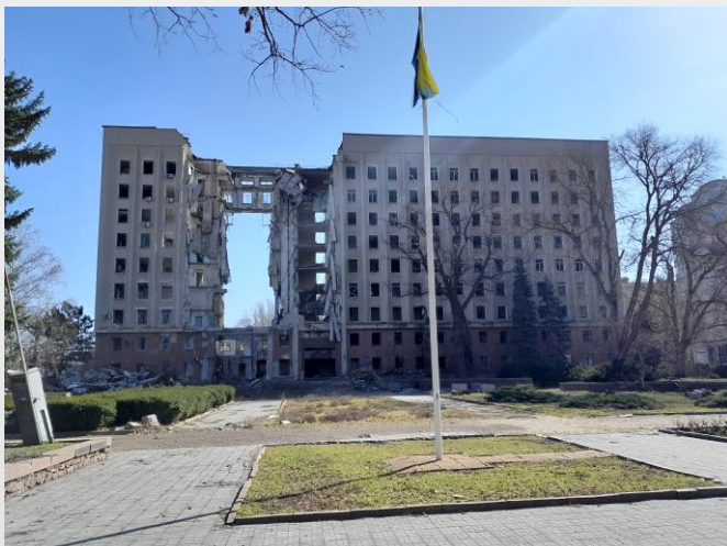
Immeuble touché par une attaque aérienne.
